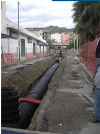
POSA DELLA TUBAZIONE
