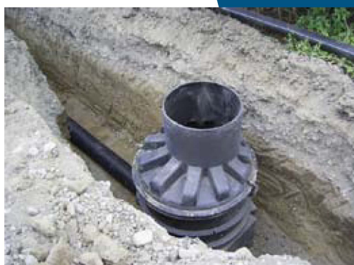
POZZETTO IN LINEA
