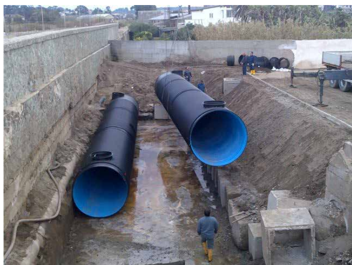
Posa dei serbatoi
