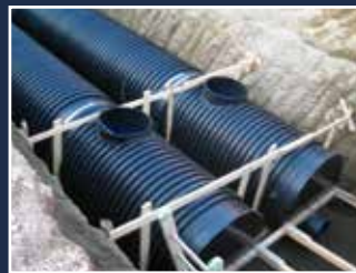
Roma, pargheggio con accumulo antincendio
